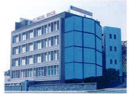
Hospital Clínica Roca, Gran Canaria
